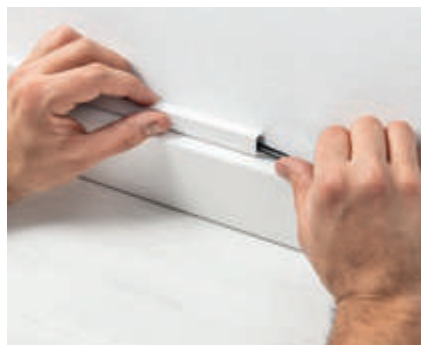
5. Inserire i cavi. Install cables.
