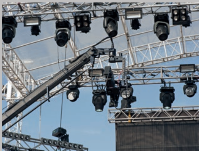
ILLUMINAZIONE ESTERNA | OUTDOOR LIGHTING
